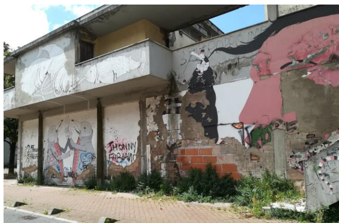
Fig. 5 – Degrado e abbandono nel quartiere “Shangay”. Questo, in particolare, è il muro adiacente alla casa del popolo, nella piazzetta centrale del quartiere.
